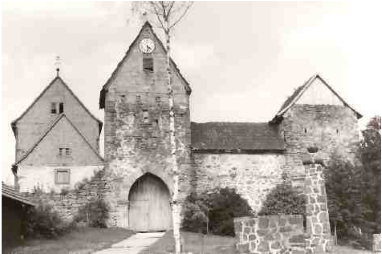
Die Kirchenburg von Serrfeld, aufgenommen vor ca. vier Jahrzehnten.
